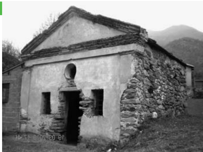
Lavori di ristrutturazione della Cappella di Airale: risistemazione tetto e interno
