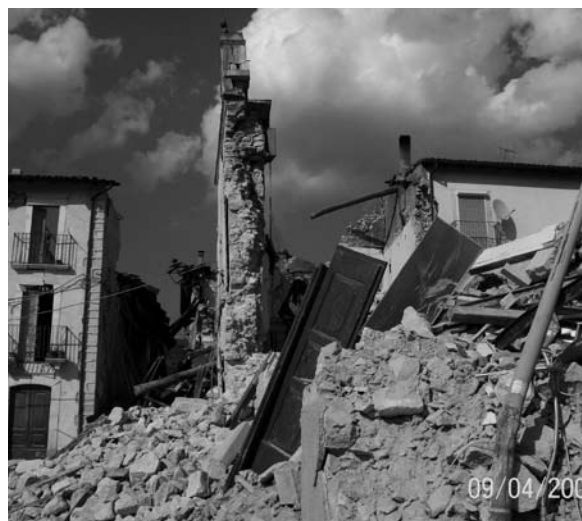
La chiesa del paese dopo il terremoto
