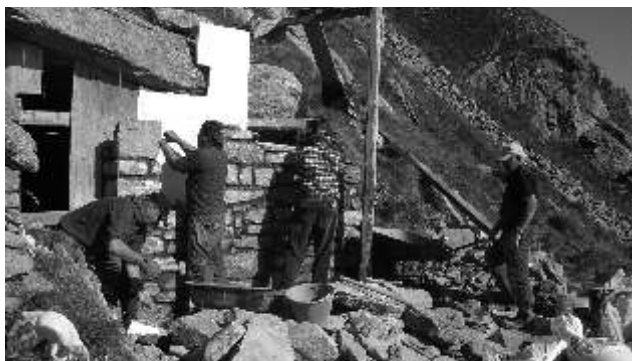
I lavori in corso d'opera
